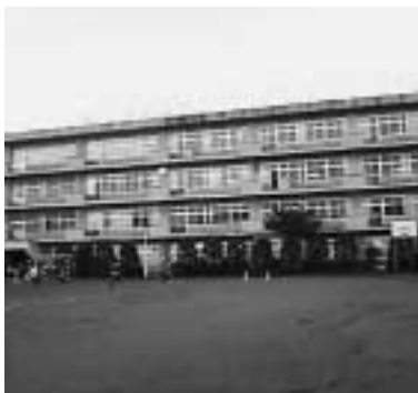
耐震工事が遅れている学校
