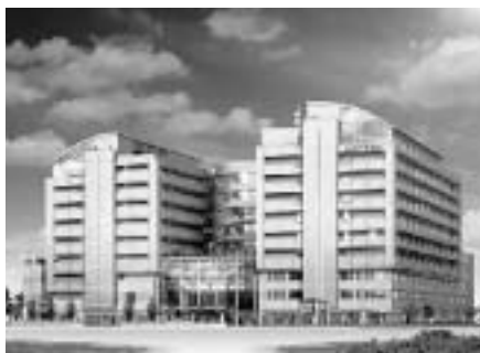
二・三期工事完成後の市民病院
