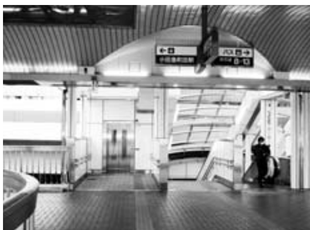
エレベーターが設置された町田バスセンター
