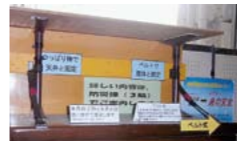
家具転倒防止器具の取り付け例
