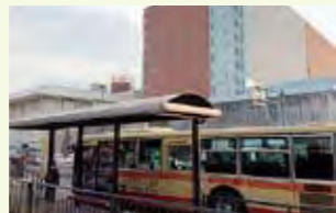
新庁舎前のバス停に設置された屋根とベンチ
