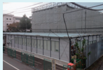
建設中の忠生市民センター
