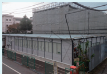
建設中の忠生市民センター
