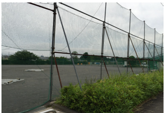
調節池建設に伴い使用できなくなる鶴間スポーツ広場
