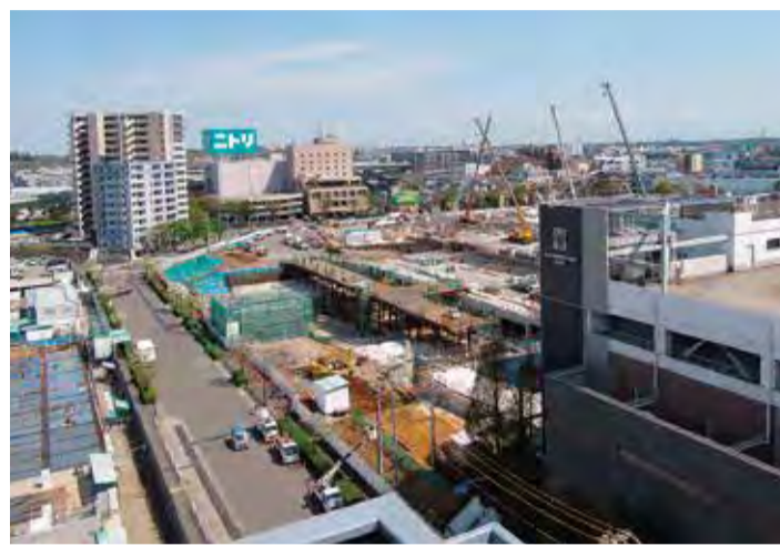
工事中の南町田グランベリーパーク
