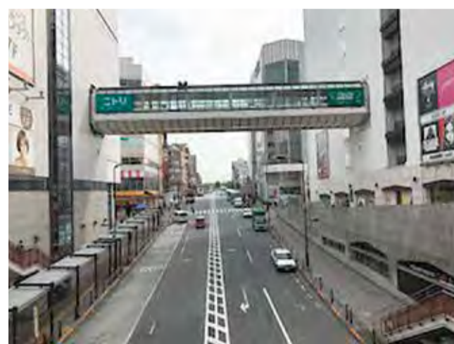
モノレール駅が予定されるJR町田駅前
